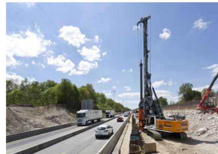
Ein Liebherr-Drehbohrgerät vom Typ LB 24-270 arbeitet an der Pfahlgründung der neuen Autobahngalerie bei Germering.
