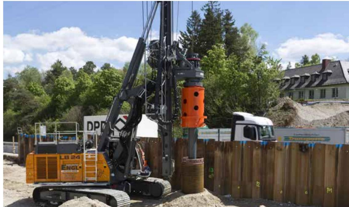
Ausgestattet mit einem Bohrantrieb vom Typ BAT 270 bringt ein Liebherr-Drehbohrgerät Gründungspfähle mit einer Länge von 12 bis 14 m ein.
