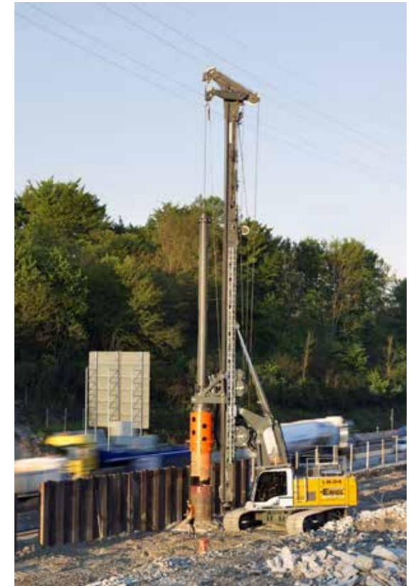
Dank seiner kompakten Abmessungen eignet sich das Drehbohrgerät LB 24-270 von Liebherr für Bohrarbeiten in unmittelbarer Nähe der Autobahn.
